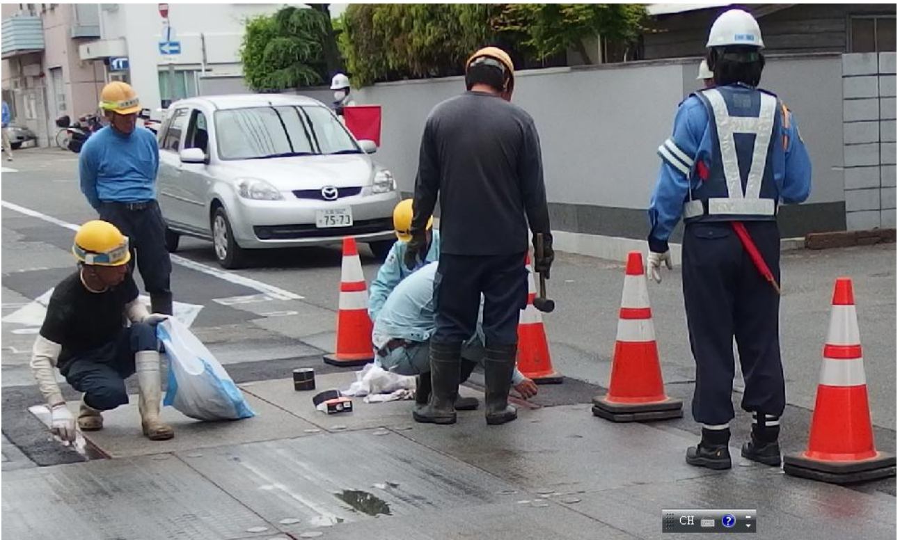
馬路施工一塵不染
